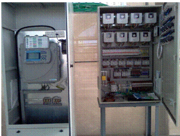
תצלום 3. ארון ווסתי התדר (מצד ימין) וארון מערכת הבקרה עם בקר גלילאו (מצד שמאל).
