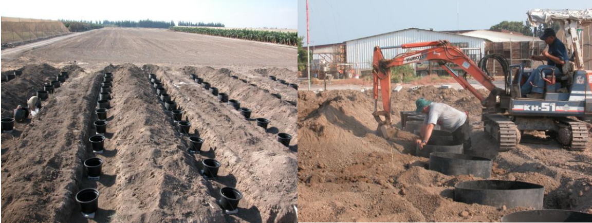
תמונה 1. שמאל: חביות בתוך התעלות; ימין: הנחת החביות בתעלה וכיסוי בעפר.
